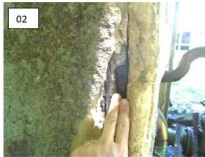
Estrutura comprometida – casa de máquina desativada
